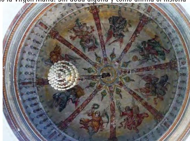
Ilustración 3: Frescos de la cúpula de la Ermita de la Asunción o La Labradora en los que se aprecian desconchones, agujeros y humedades que han provocado que algunas partes se hallan perdido.
